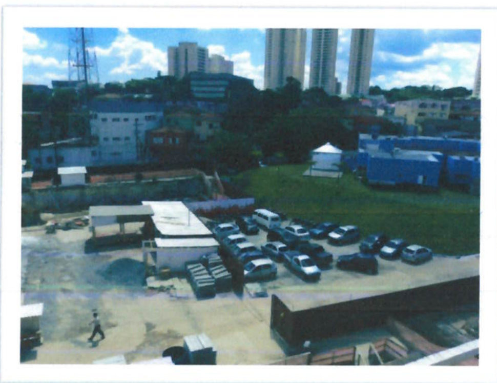
Figura 18 – Construções provisórias construídas a partir de compensado de madeira reciclada.
