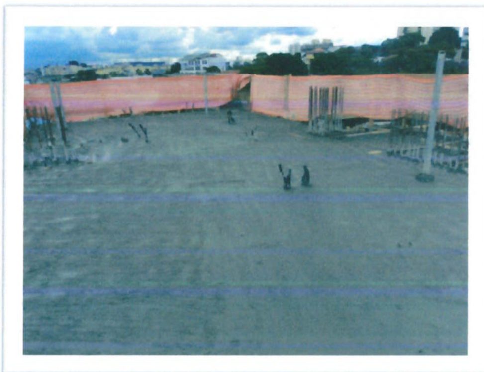
Figura 21 – Redes para proteção instaladas canteiro – 1, durante a fase de concretagem da laje.
