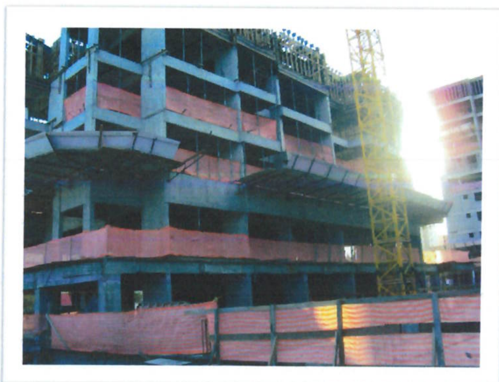
Figura 20 – Redes para proteção instaladas canteiro - 2.
