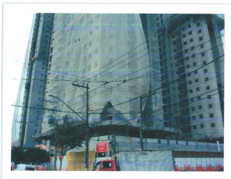
Figura 17 – Tapumes de compensado de madeira reciclada.
