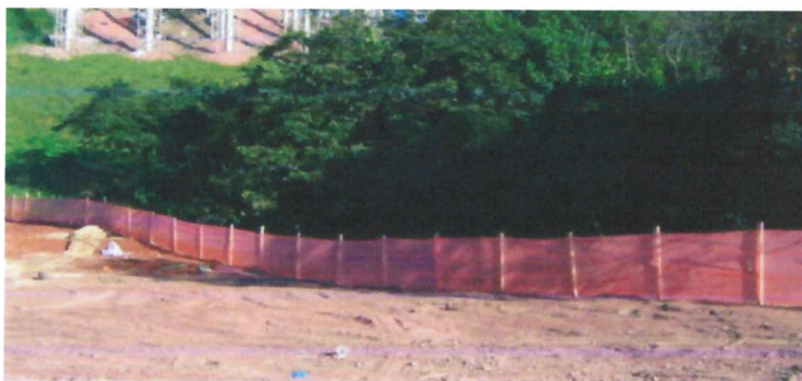
Figura 23 – Proteção de máximo arbóreo durante a execução da obra.
